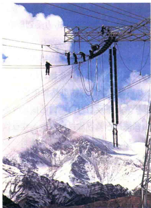
建设中的青藏联网工程。
