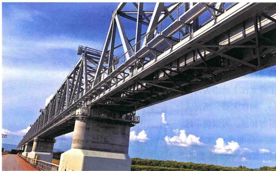
建设中的中俄同江铁路大桥。
