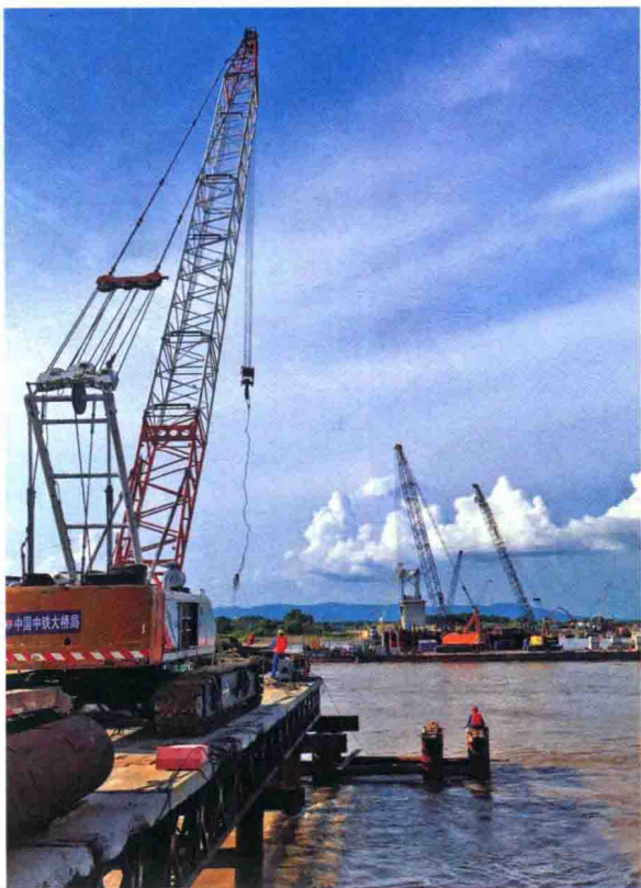
中俄同江铁路大桥建设现场。
