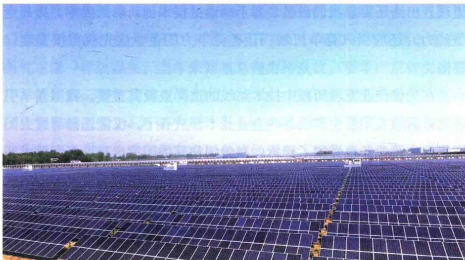
安徽省金寨县信义小南京光伏产业园。
