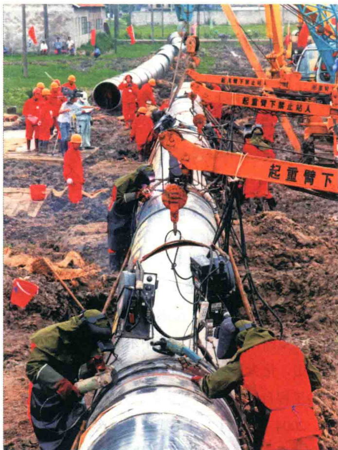
西气东输工程管道建设现场。
