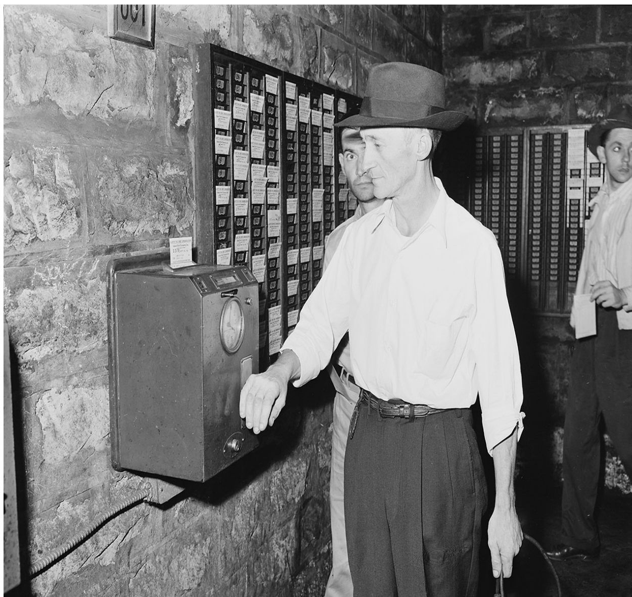
图8.4 “时间就是金钱。”一名煤炭工人从位于肯塔基州弗洛伊德县的内陆钢铁公司下班，约1946年或1947年。图自美国国家档案馆
