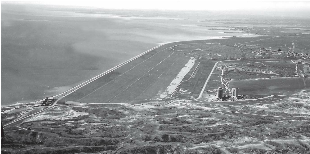
图1.18 朝北方向的佩克堡大坝现状
