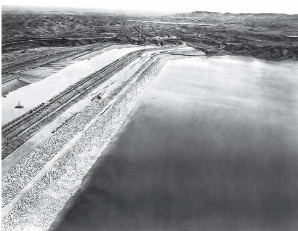
图1.16 坍塌滑坡前的佩克堡大坝
