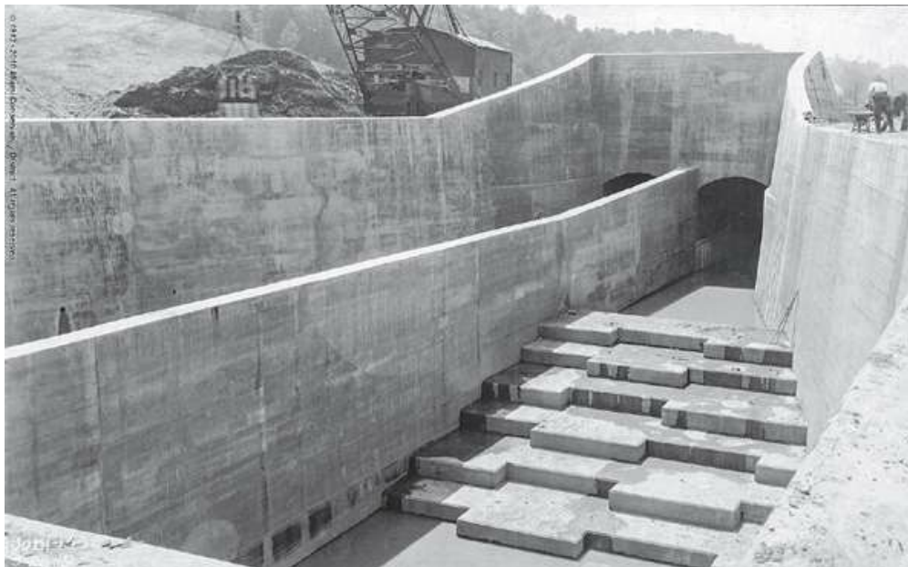
图2.4 施工期间的日耳曼敦大坝
