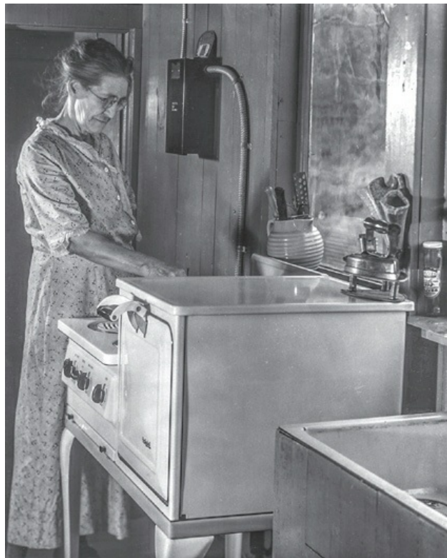
图2.11 电灶由TVA电力提供
