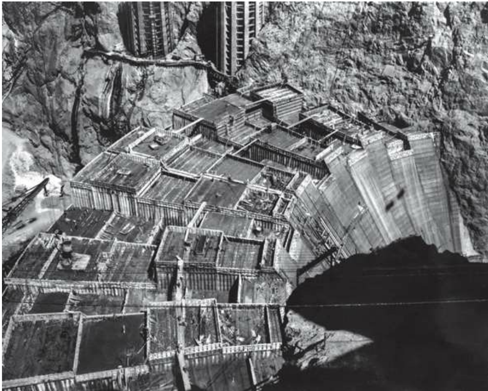
图1.8 胡佛大坝的混凝土浇筑
