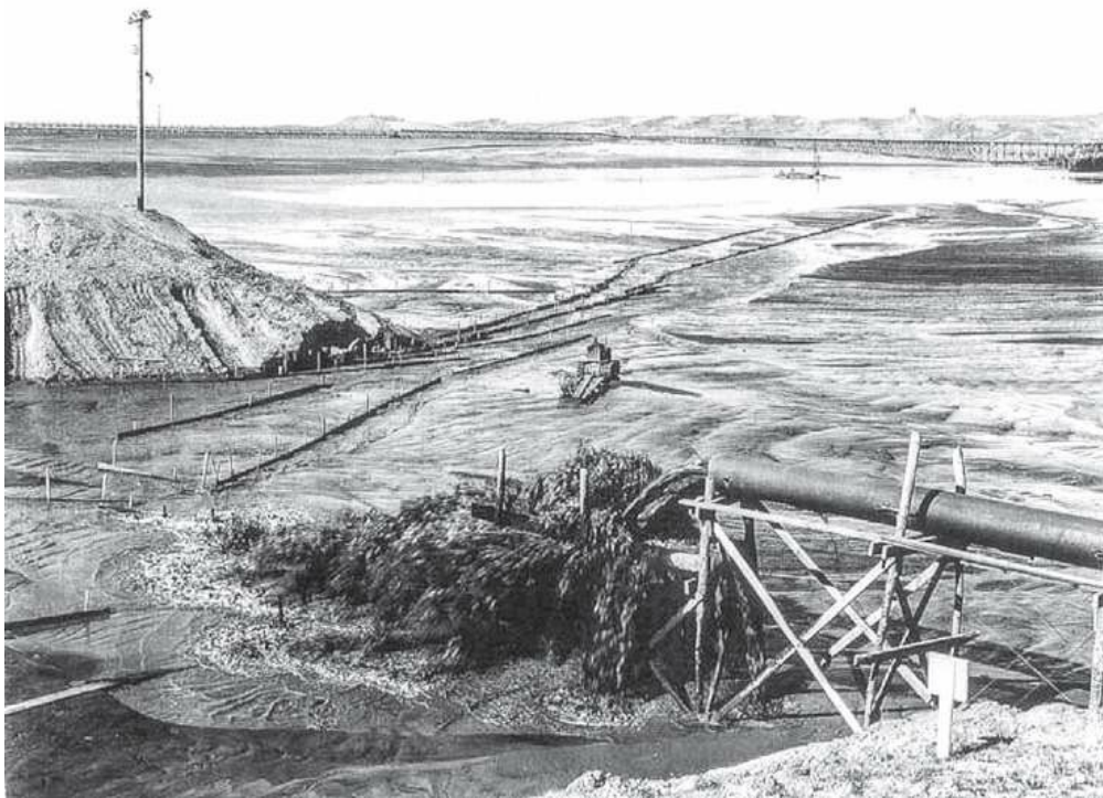
图1.15 使用抽水式液压填土加高佩克堡大坝
