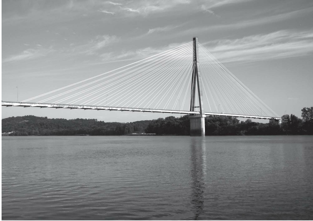
图3.16 俄亥俄河上方的东亨廷顿桥
