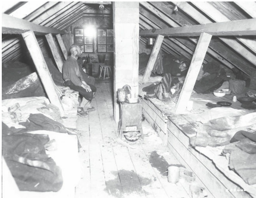
考弗灵一座卫星营的小屋（解放后拍摄）。党卫队把囚犯塞入这样一间害虫滋生、稻草或泥土为顶的小屋。
