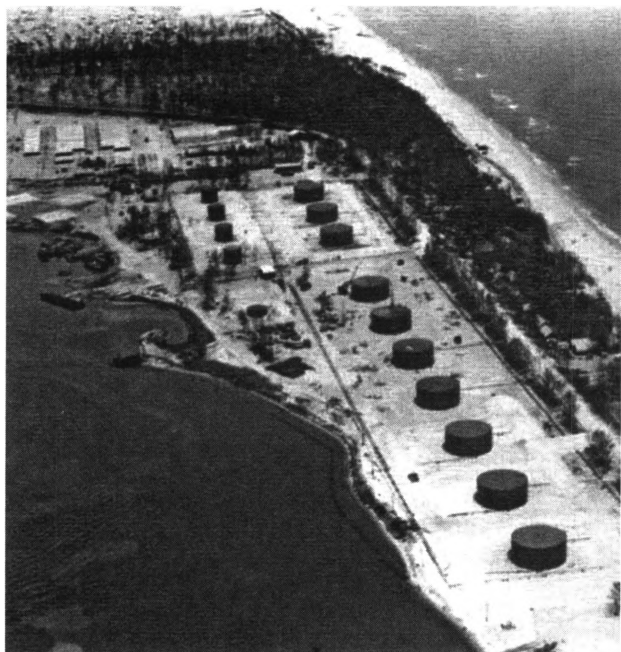
图 5.5 在顺安附近重建的油料罐区
