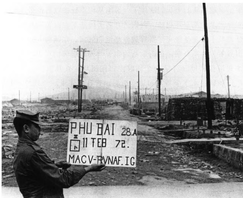
图 0.1 富牌战斗基地被拆除的部队营房，1972 年 2 月 11 日
