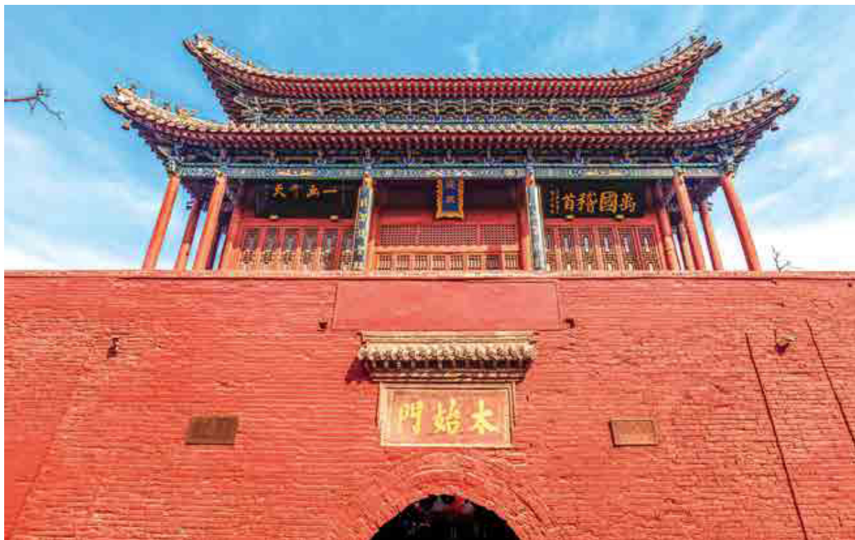
图142 淮阳旧名郢陈，故城位于今周口市淮阳区，图为明洪武年间在淮阳古城太昊陵原址重建的太始门
