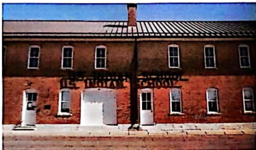
内布拉斯加州热内亚原住民寄宿学校旧址
