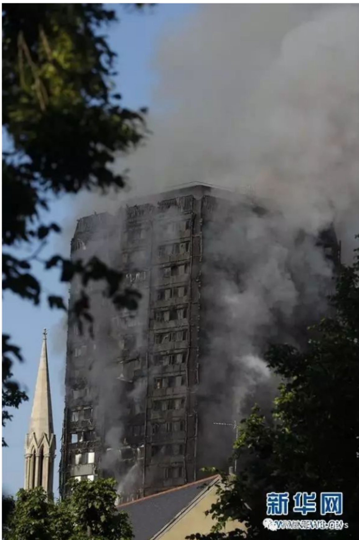
上图是起火的大楼烧完之后的状况.....
