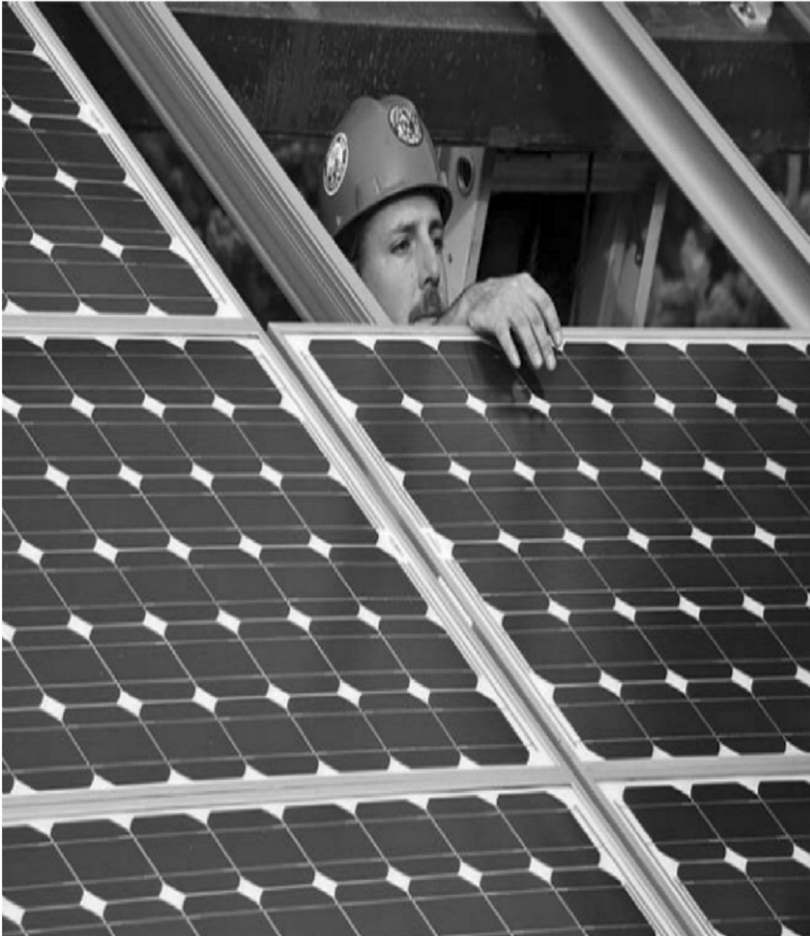
图21.1 正在安装太阳能电池板 资料来源：维基共享资源。
