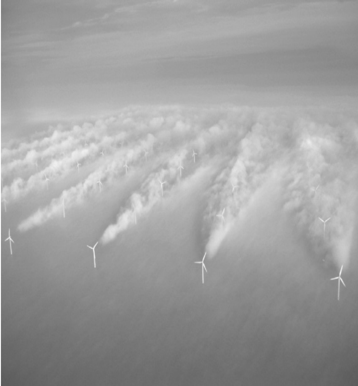
图15.2 风力受到涡轮机的影响 资料来源：丹麦 Vattenfall Horns Rev 项目。
