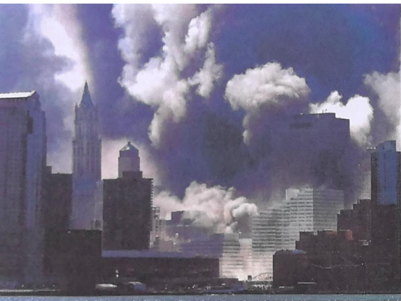
△世贸中心双子塔在遭撞击后坍塌
