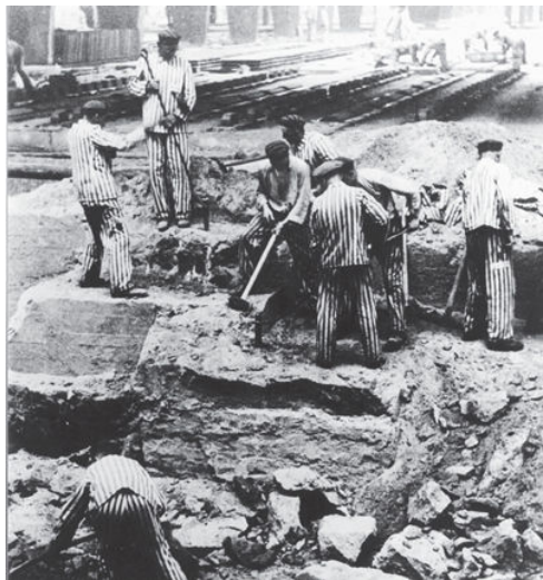
1940年，捷克囚犯用基本工具拆除萨克森豪森集中营附近党卫队一处建设失败砖窑的水泥地基。
