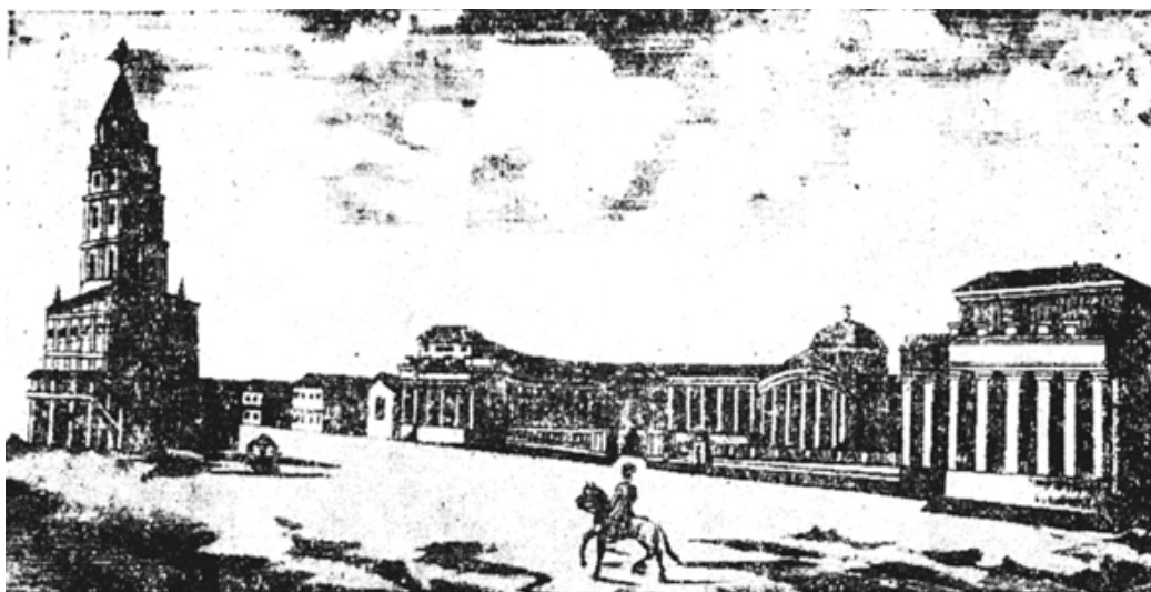
图7-1 苏哈列夫塔楼（航海学校）
