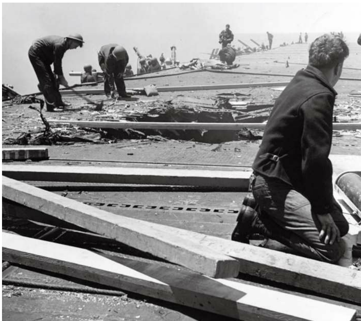
42. 1942年6月4日，“约克城号”损管人员正在修复被250千克炸弹炸开的甲板
