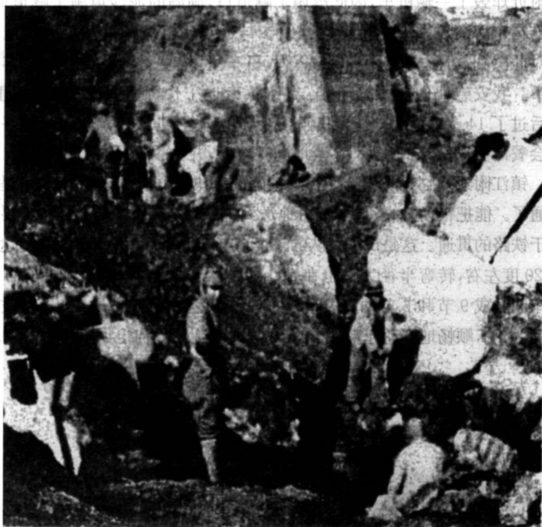
被毁坏的镇江隧道入口
