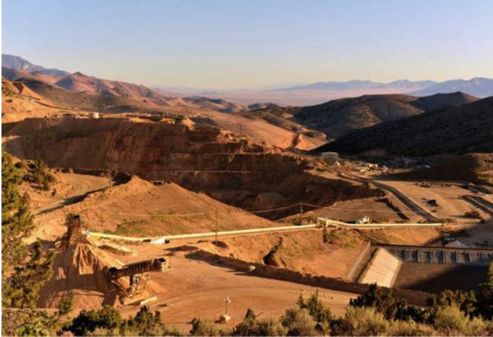
图1-8 科尔-罗切斯特露天矿场的堆浸工艺加工设备
