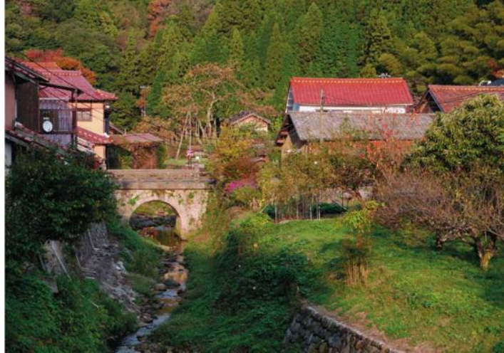
图2-15 石见银山遗址的石桥
