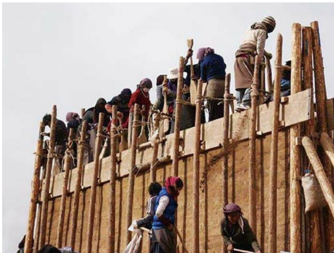
模拟版筑墙垣场景（网易号“大国工匠”）
