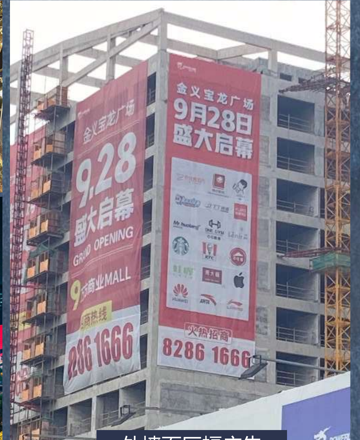
外墙面巨幅广告
