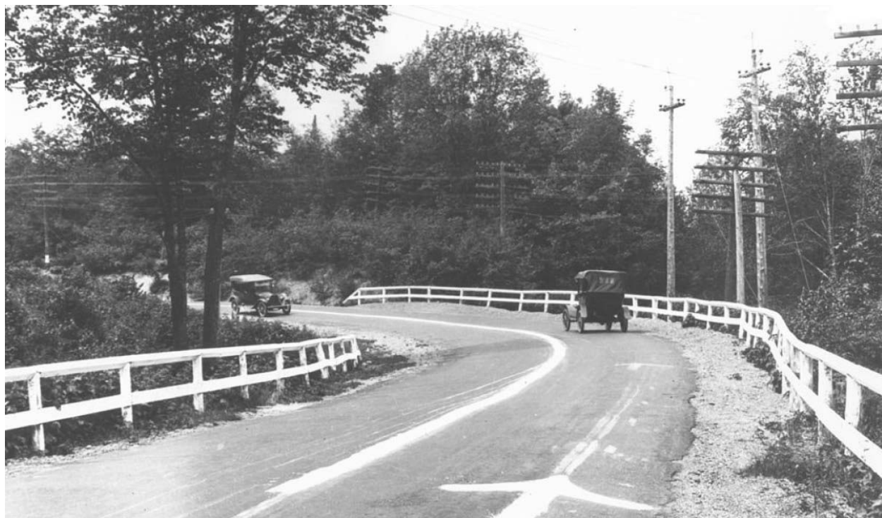
图1-1 针对“白线”这种特殊的助推手段，美国迅速投入使用，到1917年的时候，好几个州的公路都漆上了白线。（1917年，密歇根州马凯特县的“死人角”马路被手工漆上了白线。）（照片由密歇根州交通部提供）
