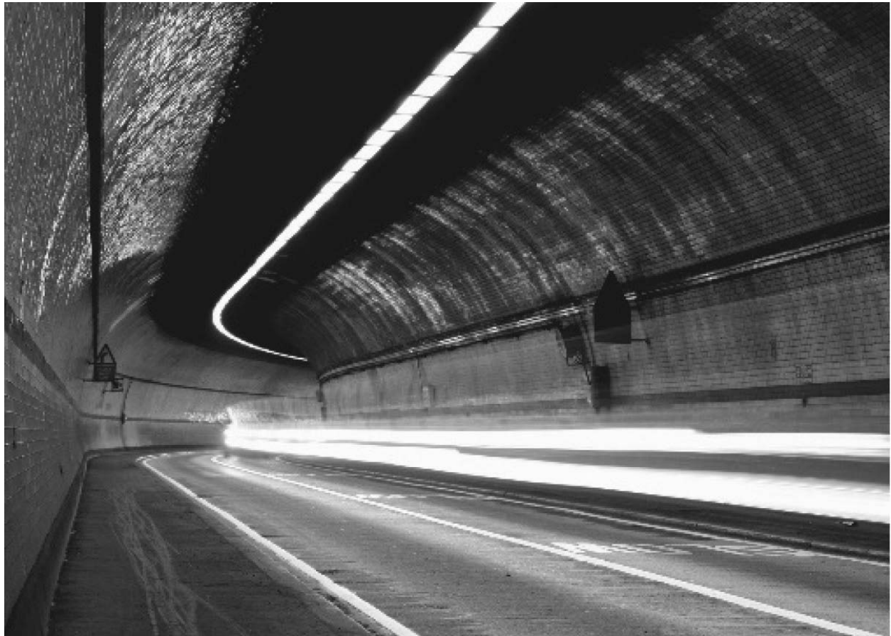
图1-2 泰晤士河下的罗瑟希德隧道于1908年开通。隧道内现在被认为十分危险的连环急转弯，过去曾被用来限制马匹的速度，以免马匹看到远处的光线而脱缰失控（照片由巴尼·莫斯提供）
