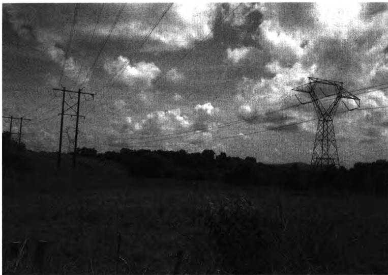
图 4-1 输电线路穿过西弗吉尼亚州的东部狭长地带。通常情况下，这些线路是相互平行的，因为输电线路的建设者更容易在现有线路旁边获得通行权，或直接使用现有通行权
