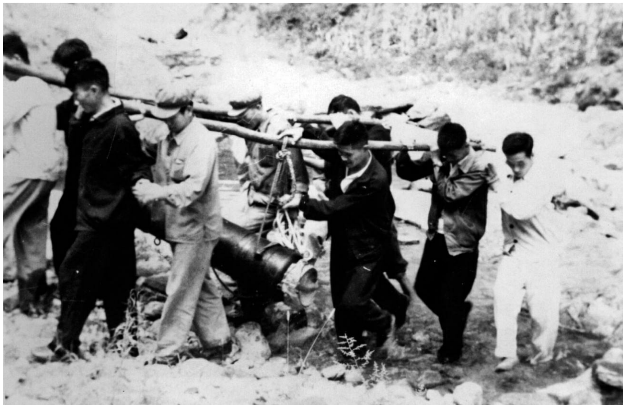
▲ 肩扛人抬，搬运设备进山
