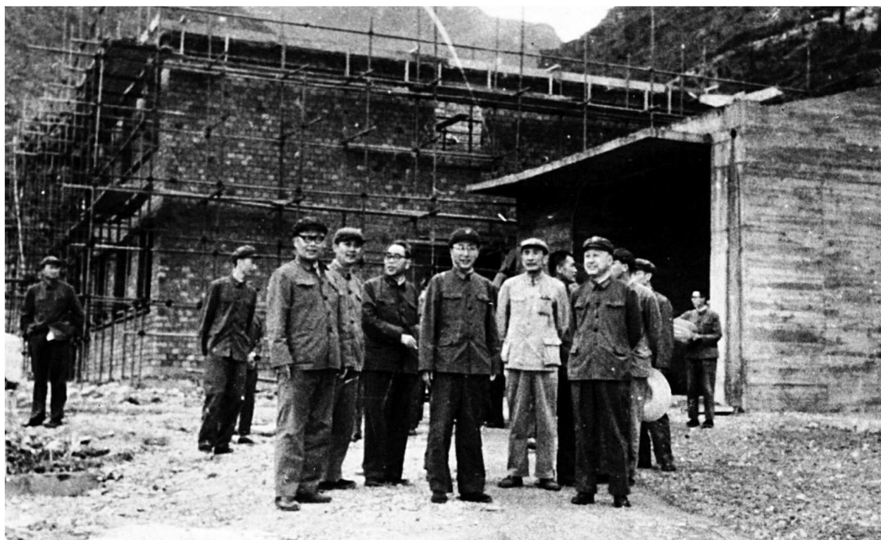
▲ 1978年5月钱学森（前排右一）到建设中的气动中心视察
