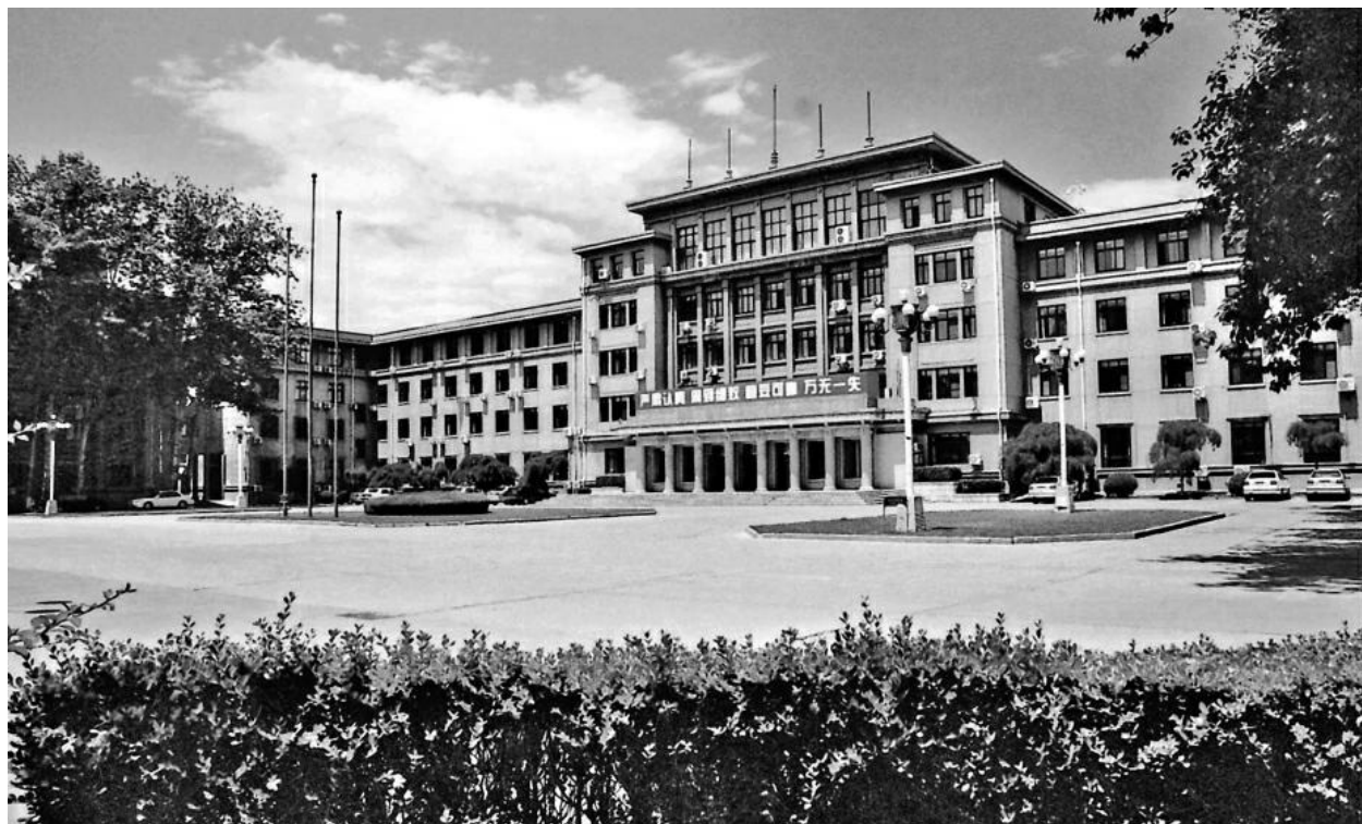
▲ 1. 国防部五院一分院办公大楼
