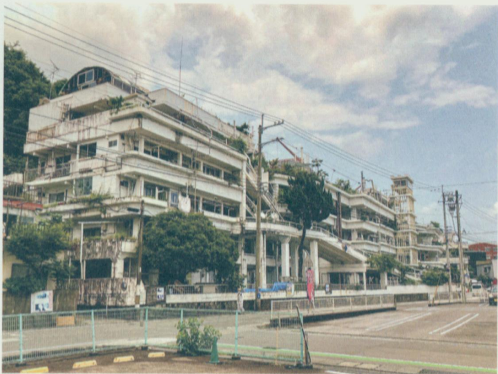
泽田嘉农和妻子裕江携手自建的钢筋混凝土集合式住宅——泽田公寓。
