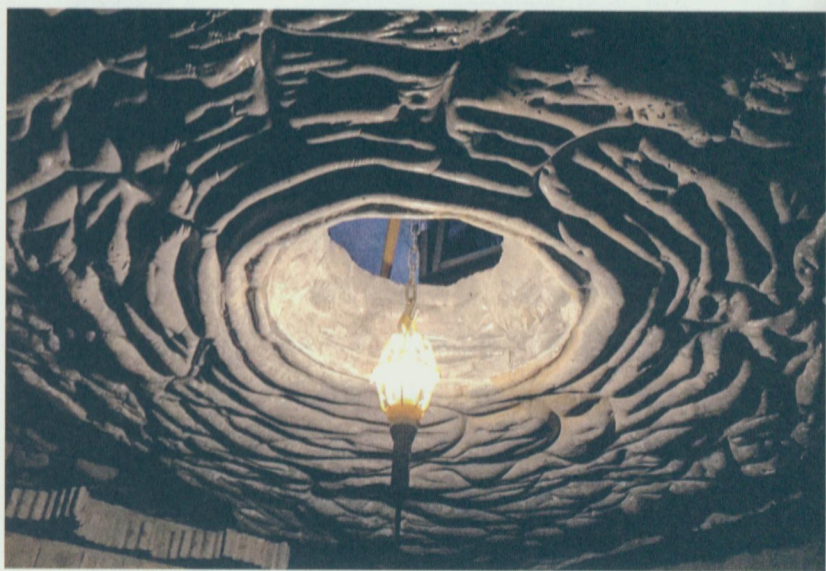
地下室底层的天花板。“用普通木板和农业用塑料做模板，搅拌后的混凝土浇在其中成型”，采用塑料膜之后混凝土的成型更加自由了，地下室的天花板借助藤蔓成型，为地下室增添一种动力和生命力。
