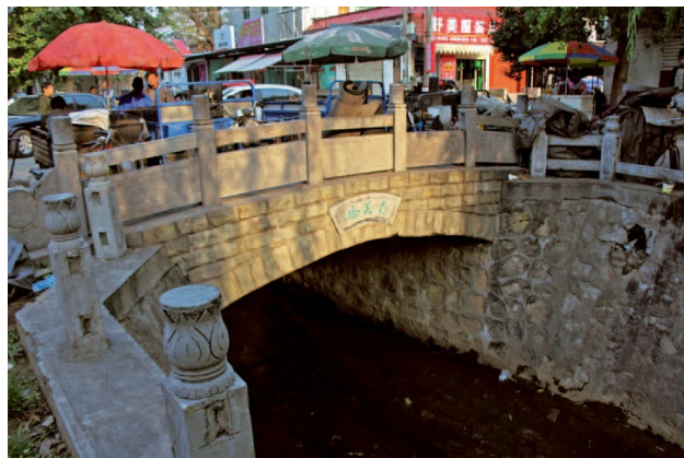
修武南关桥上人流不断
